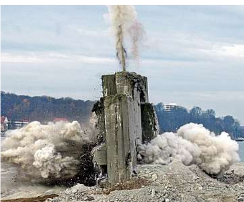
Scheitern und Scheitelpunkt für Mahnmal Kilian: Zur Jahrtausendwende wurde der U-Bootbunker am Ostuferhafen gesprengt.
